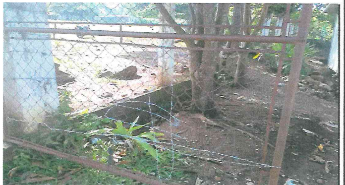
Foto 4: Portón de ingreso deteriorado.
